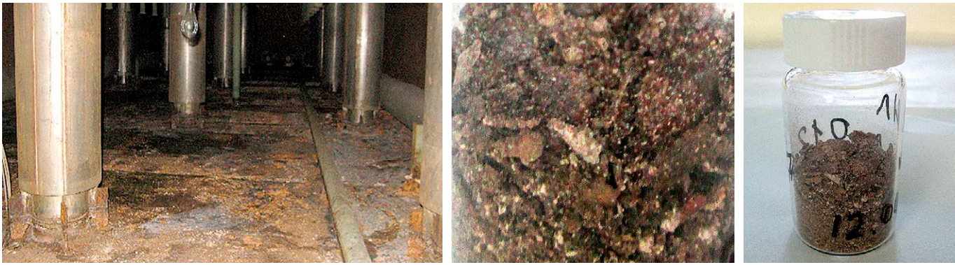
Рис. 4. ДВ, відібрані в приміщенні 012/7 об'єкта «Укриття»
