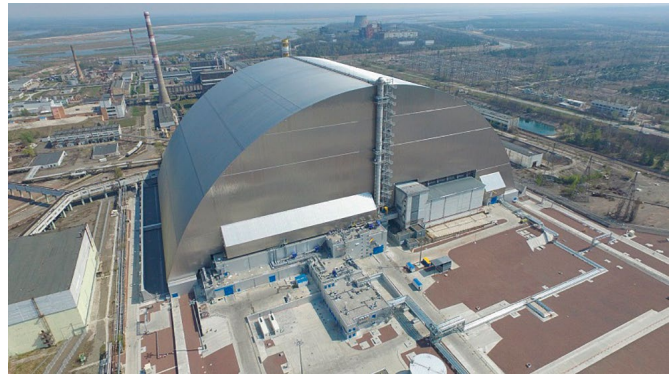
Рис 1. Загальний вигляд Нового безпечного конфаймента
