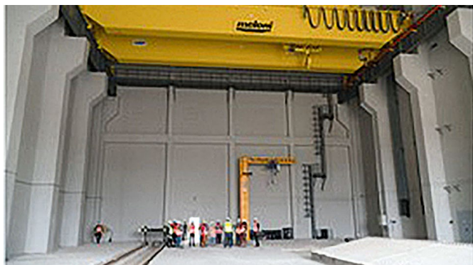
Рис. 8. Будівля приймання відпрацьованого ядерного палива
