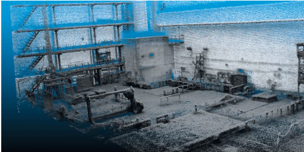
Рис. 5. Візуальна картина («хмара» точок) центрального залу зруйнованого реактора 4-го енергоблока ЧАЕС
