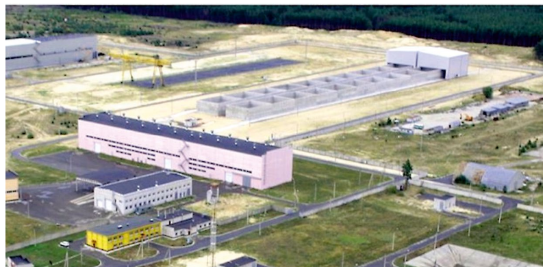
Рис. 6. Побудоване приповерхнєве сховище модульного типу на КВ «Вектор»
