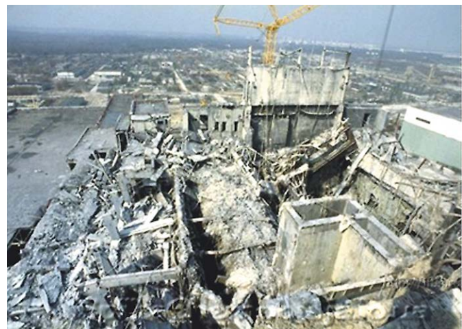
Рис. 1. Завали будівельних конструкцій у зруйнованому 4-му блоці Чорнобильської АЕС
