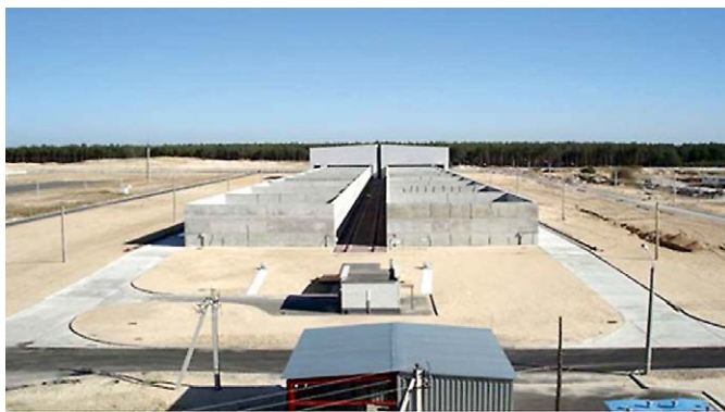
Рис. 2. Приклад будівлі приповерхневого сховища
