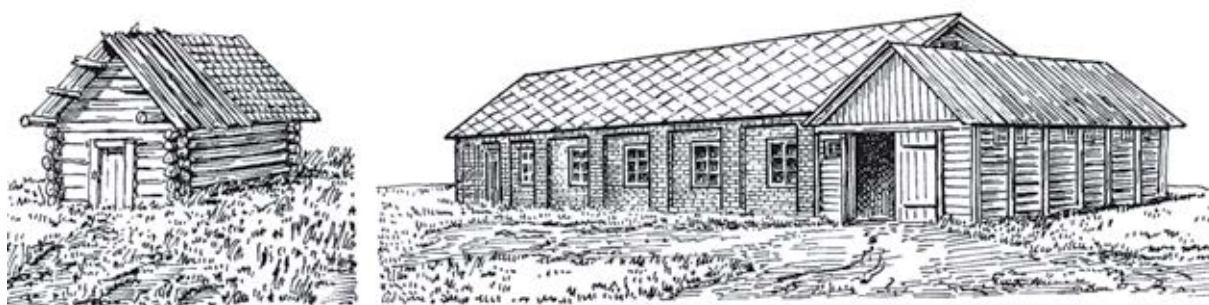
Ил. 1. Новозбудована колгоспна ремонтна майстерня та стара успільнена кухня
