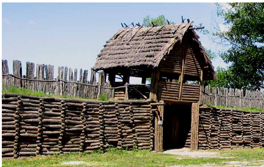
Ил.13. Пример двухъярусного укрепления. Польша. Город Бискупин. Реконструкция простой деревоземляной стены из городен, которые забучены землей. Боевая площадка защищена частоколом. Вид со стороны поселения.
