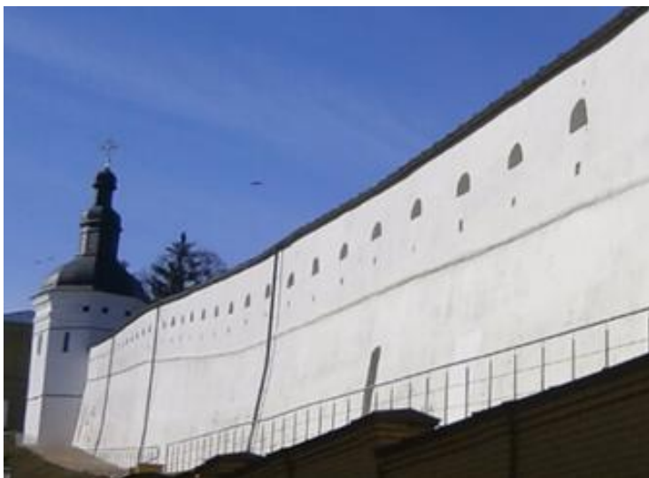
Лл. 26. Південна башта та ділянка монастирських мурів № 2 Києво-Печерської лаври. Загальний вигляд з південного сходу, де над бійницями влаштовані великі арочні прорізи
