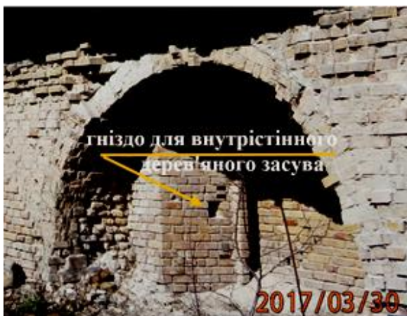
Лл. 30. Західний укіс дверного прорізу до першого ярусу Кутової башти
