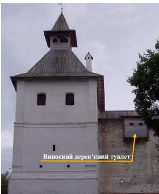
Лл. 10. Східна вежа Спасо-Преображенського монастиря у Новгороді-Сіверському після реставрації. Вигляд з боку поля. Вежа мала пічне опалення та виносний дерев'яний туалет в рівні бойового ходу монастирського муру. Фото 1998 р.
