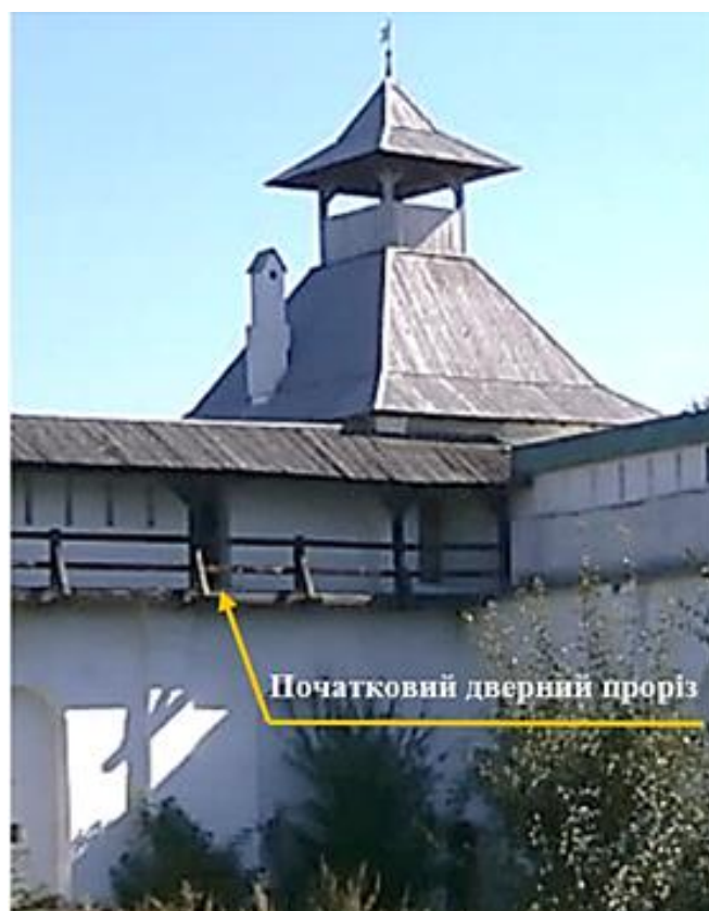
Лл. 11. Східна вежа Спасо-Преображенського монастиря у Новгороді-Сіверському після реставрації. Вигляд з боку монастирського подвір'я. Початковий дверний проріз, що зберігся – це вхід до зовнішнього виносного туалету
