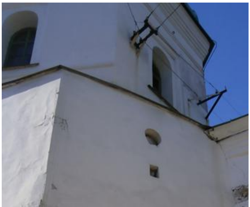
Лл. 23. Фрагмент східної грані фасаду башти Івана Кушника. Над прямокутною бійницею круглий вентиляційний отвір
