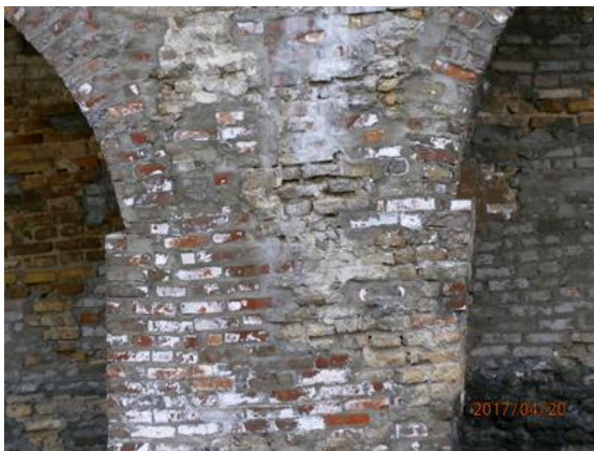
Іл. 40. Фрагмент простінку з поличками для встановлення кружал на ділянці монастирських мурів №2
