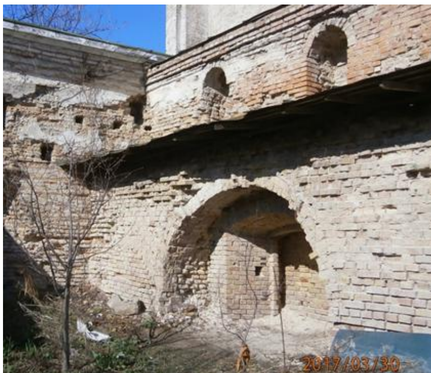
Лл. 29. Сучасний вигляд дверного прорізу з боку монастирського подвір'я до першого ярусу Кутової башти (не зберіглася)
