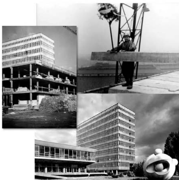
Фото 9. Будівництво Інституту хімії у Вроцлаві
