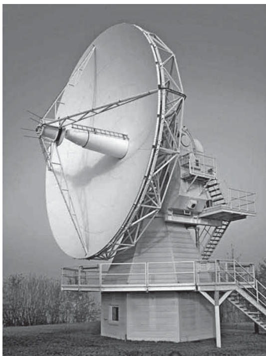
Рис. 1. Антенна АДЭ-13 для радиотелескопов РСДБ-сети нового поколения
