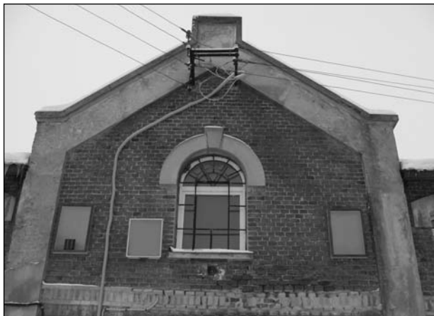
Рис. 4. Встановлення сонячних теплових повітряних колекторів на будинку лабораторії відновлювальних джерел енергії Львівського національного аграрного університету
