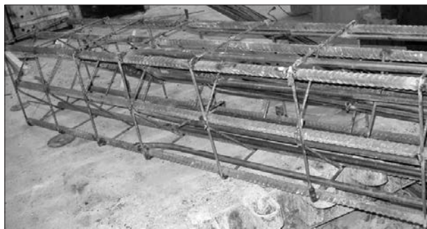
Рис. 1. Загальний вигляд арматурного каркасу зразка колони
