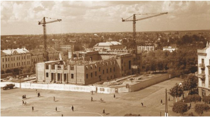
Фото 5. Будівництво драмтеатру, 1958 р. 41
