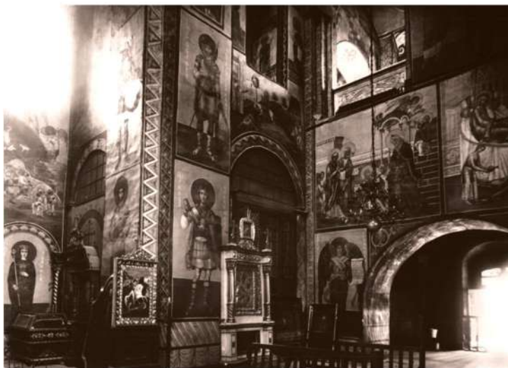
Рис. 12. Вигляд на середню кліть південної нави. Огородження приділа у верхній частині має заокруглене завершення із заскляними рамами для проникнення світла. Фото 1930-х рр.
