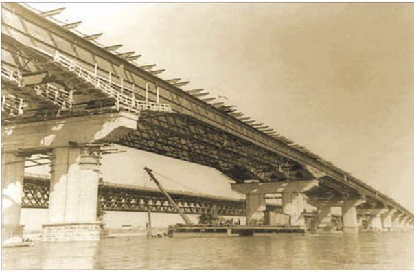
Рис. 6. Прогонні будови мосту через Дніпро у Києві в період будівництва
