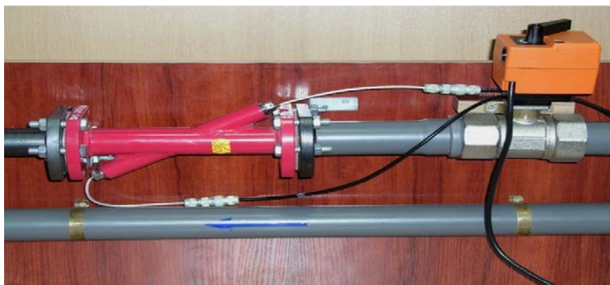
Рис. 1. Фрагмент прямого та зворотного трубопроводів теплового пункту з витратомірною ділянкою тепловоділічильника СВТУ-10М і клапаном вузла регулювання витрат теплоносія (макет)
