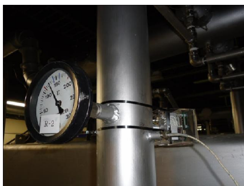
Рис. 10. Установка встроенного в ТЭГЭЭ беспроводного сенсорного узла на трубу.
