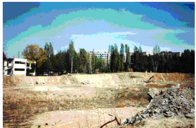
Рис. 18. Состояние цирка оползня на 22.04. 1999 г. Фото А. Костюка. Слева на фото, вблизи воронки от бывшего оползня, виден фрагмент от разрушенного и брошенного детского сада, а на заднем плане за деревьями — аварийный 9-этажный жилой дом № 9
