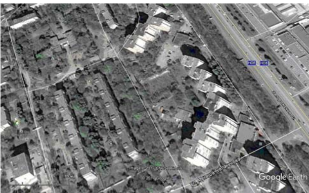
Рис. 6. Высотные дома № 56 и 58, построенные на ж/м Тополь-1 в притык друг к другу в виде “каскада” на углу Запорожского шоссе и ул. Мукаша Салакунова. Космоснимок Landsat. Дата съемки 16.04.2016. Высота над уровнем моря 155 м.
