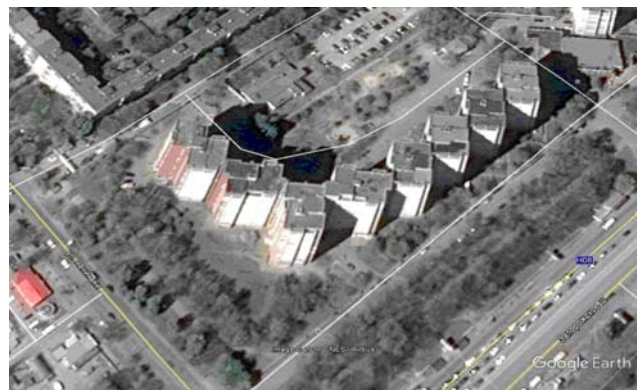
Рис. 7. Кирпичный дугообразно-каскадный высотный дом № 60, построенный на углу Запорожского шоссе и ул. Паникахи, ж/м “Тополь-1”. В левом верхнем углу снимка — дом № 15. Космоснимок Landsat. Дата съемки 17.06.2016. Высота над уровнем моря 155 м.
