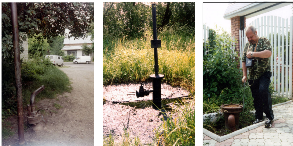
Рис. 12. Старі недіючі, покинуті свердловини — джерела забруднення довкілля вуглеводнями (на цих знімках зафіксовано лише кілька відсотків таких об'єктів)
