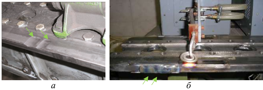
Рис. 1. Фотографія ділянки, де відбувся знос робочої поверхні рейки літака Ан-124, (а) та вид дефектної поверхні після застосування відновлювального наплавлення (б).
