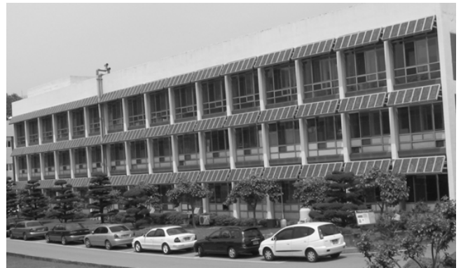
Рис. 2. Стационарно встановлені СМ на південній стіні однієї з будівель Корейського інституту енергетичних досліджень (м. Денжюон, Південна Корея).
