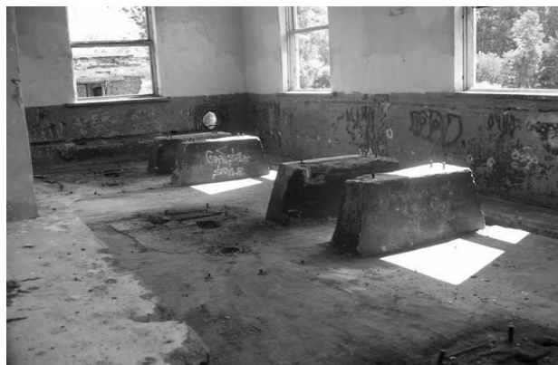
Рис. 6. Машинна зала Великосорочинської малої гідроелектростанції (340 кВт, р. Псьол, Полтавська обл.).
