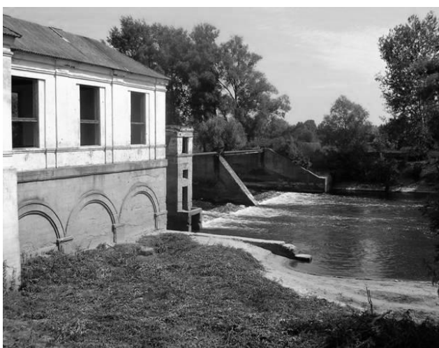
Рис. 5. Гребля та будівля Великосорочинської малої гідроелектростанції (340 кВт, р. Псьол, Полтавська обл.)
