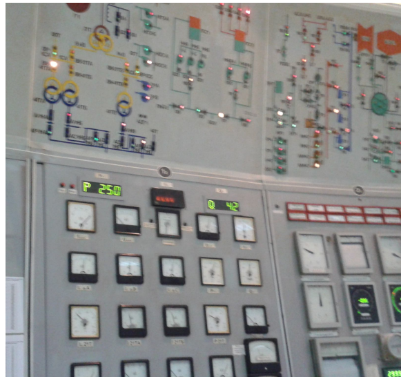
Рис. 4. Панель БЩК ТЕЦ-6 блоку №1 з показами активної та реактивної потужності енергоблоку.
