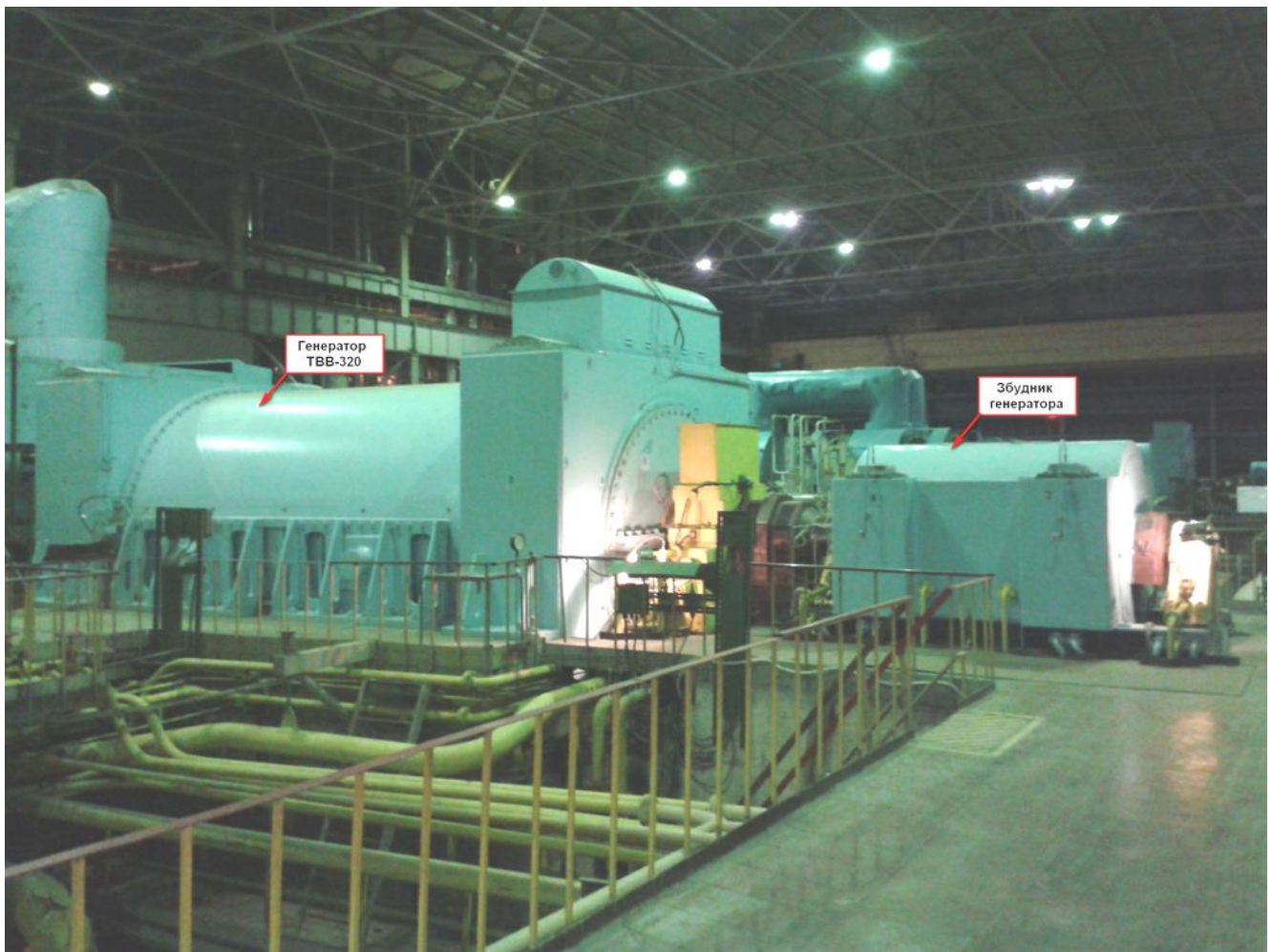
Рис. 1. Генератор та збудник генератора блоку №1 Київської ТЕЦ-6.
