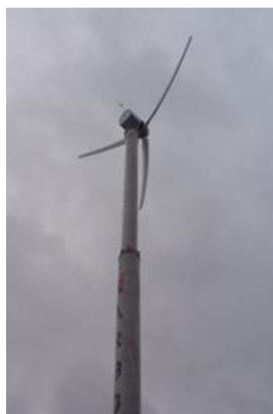
Рис. 3. Виготовлений безкорпусний безредукторний генератор для вітроустановки
