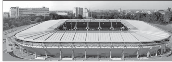
Рис. 9. Загальний вигляд стадіону «Дніпро» у Дніпропетровську
