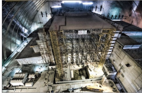
Рис. 3. Об'єкт «Укриття» під новим безпечним конфайнментом
