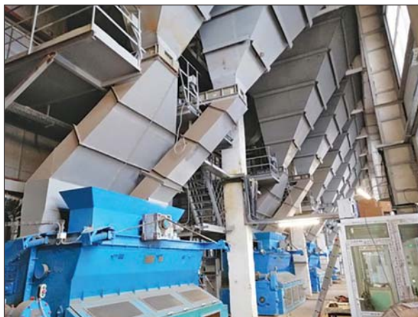
Рис. 8. Котли Хоростківського цукрового заводу, реконструйовані з переведенням на спалювання пелет з біомаси та/або газового вугілля
