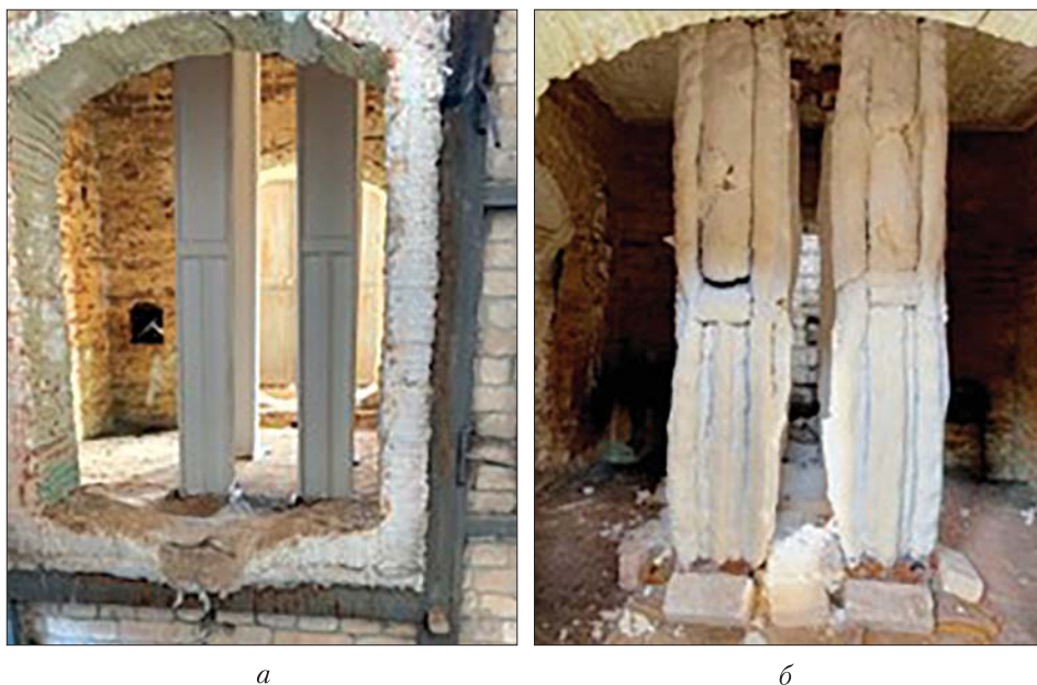
Рис. 2. Вогнезахист сталевих конструкцій з використанням: а – штукатурки; б – реактивного покриття
