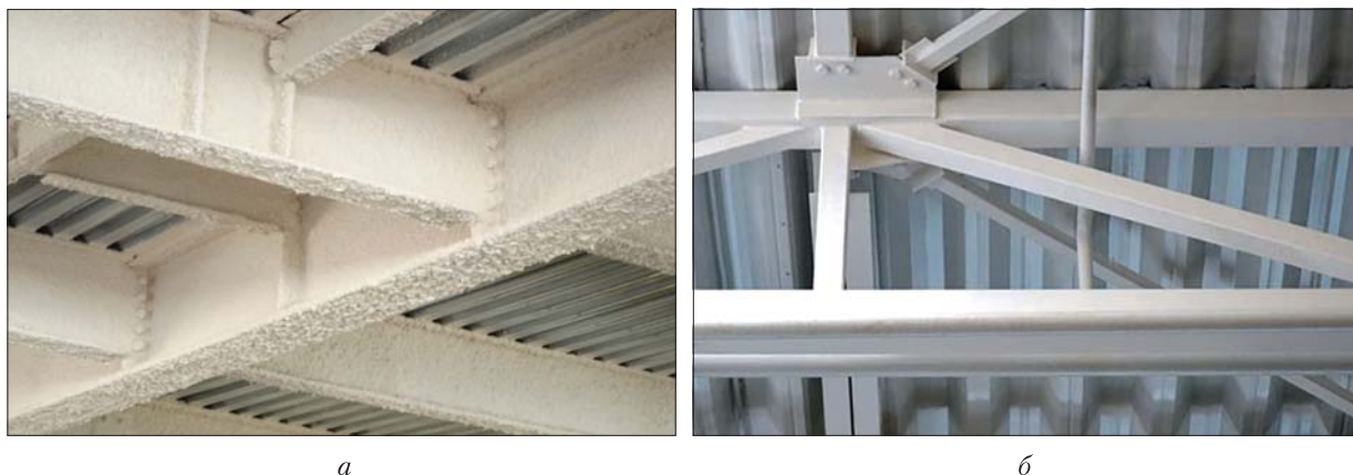
Рис. 2. Вогнезахист сталевих конструкцій з використанням: а – штукатурки; б – реактивного покриття
