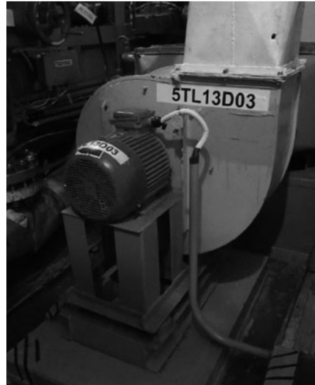
Рисунок 1 – Приклад опорної конструкції обладнання
