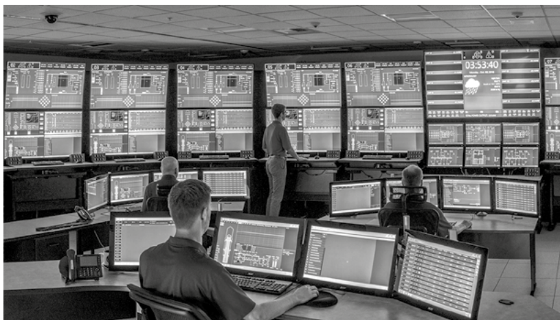
Рисунок 2 – Управління багатомодульною АЕС (БЦУ симулятора 12-модульного енергоблока АЕС з ММР NuScale)
