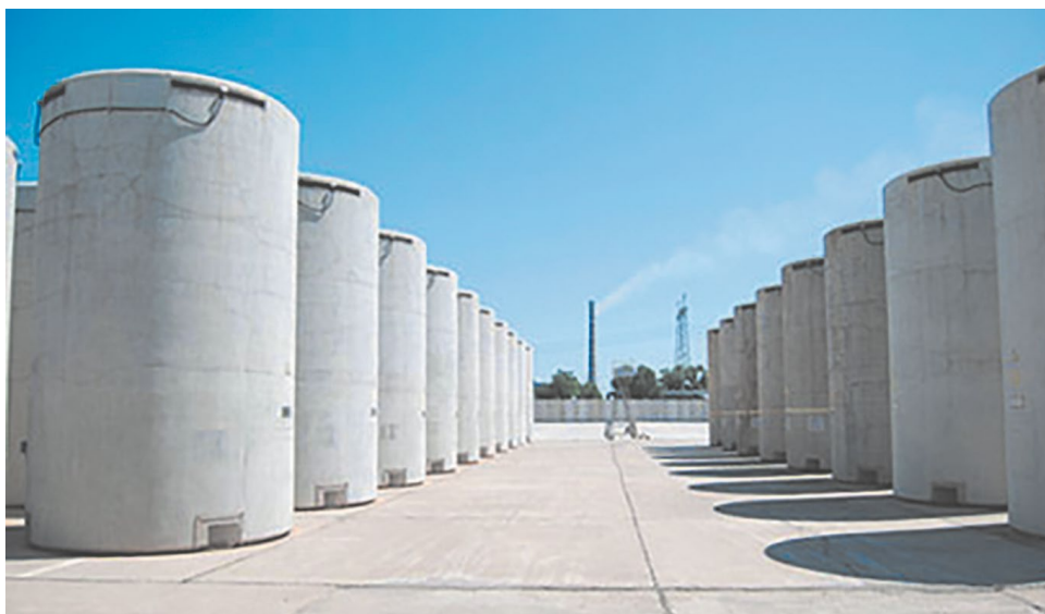
Рисунок 4 – Вентильований бетонний контейнер системи зберігання відпрацьованого ядерного палива ЦУА-159-3058 (фото https://www.npp.zp.ua/uk/activities/sfds/comparison )
