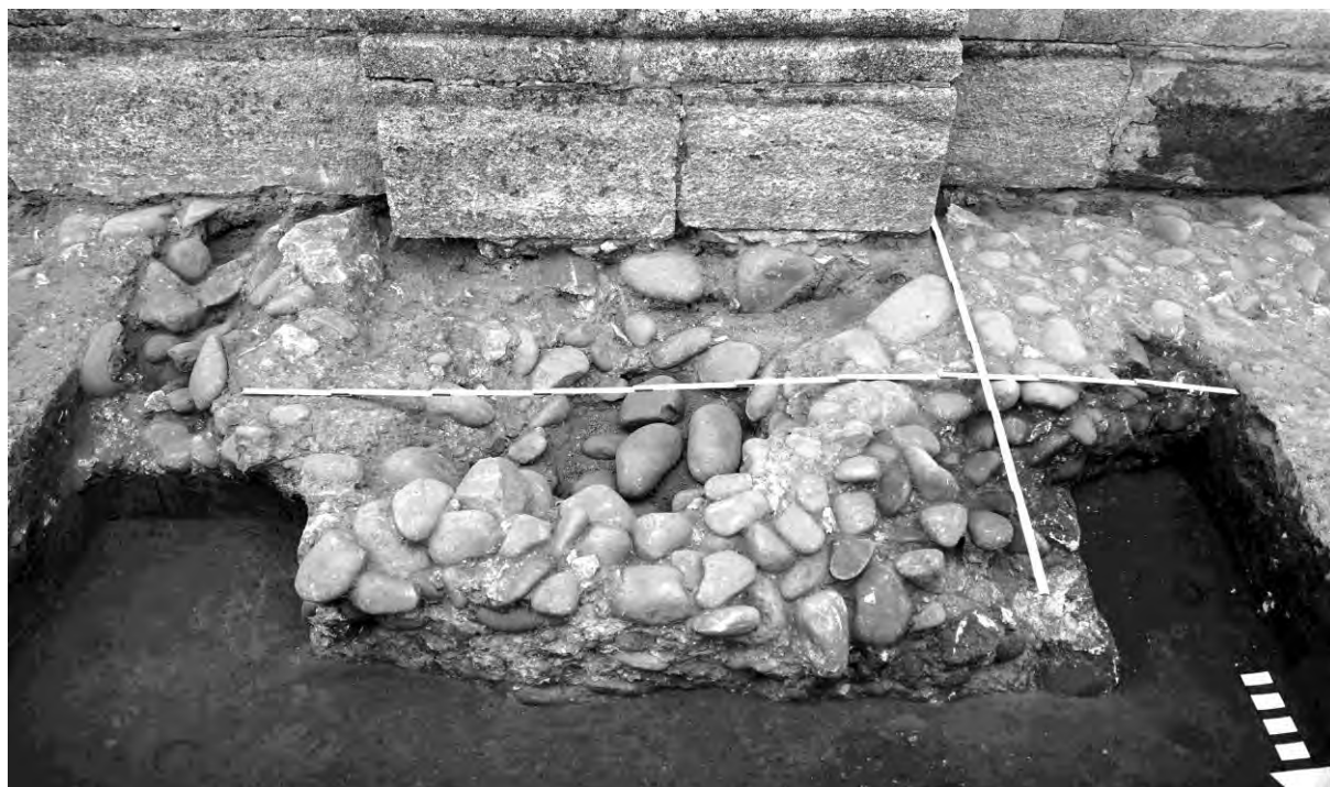
Рис. 13. Шурф 8. Виступ фундаменту напроти пілястри північного фасаду. Вигляд із півночі
