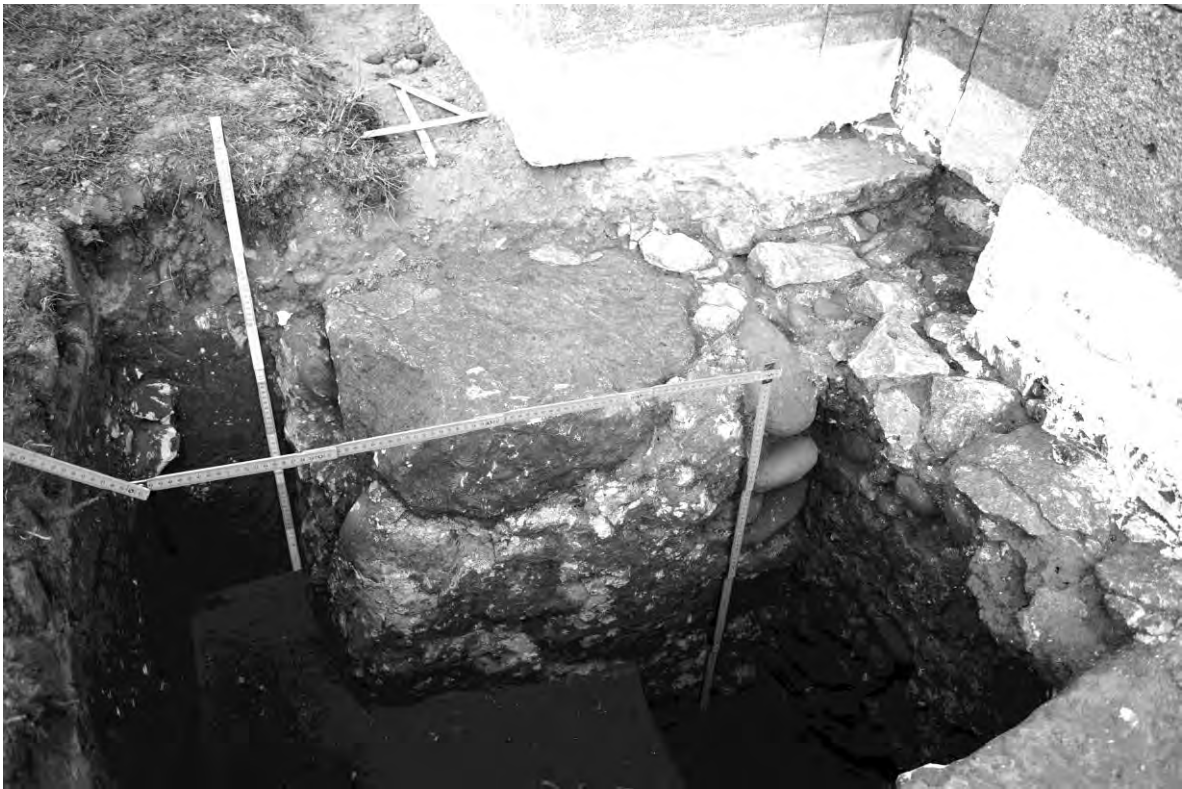
Рис. 12. Шурф 6. Домурований виступ фундаменту. Вигляд з південного заходу
