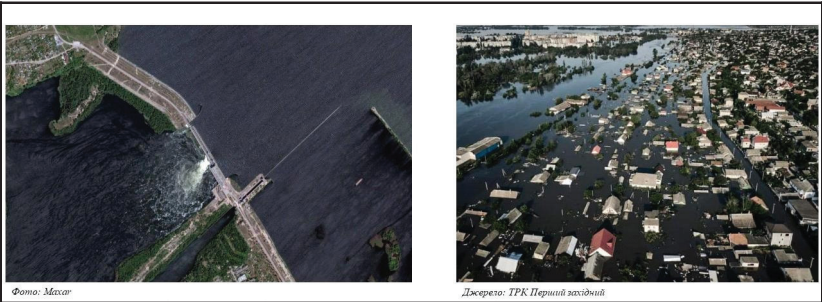
Рис. 2. Наслідки руйнування Каховської ГЕС
